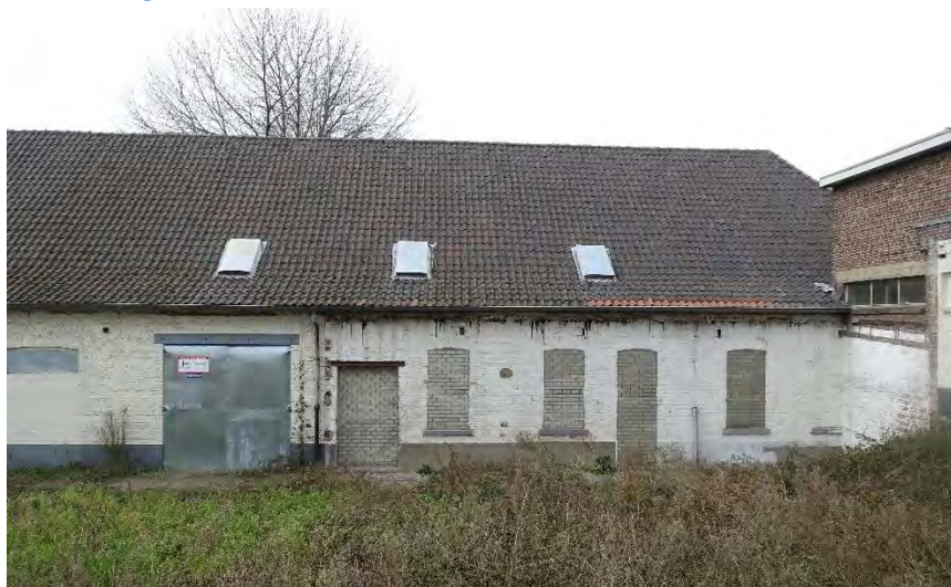
Afb. 65. Bij het onderzoek in 2025 was door sloop van het naast gelegen gebouw het noordelijke deel van de oostgevel grotendeels in het zicht gekomen. FH MAB 2025
