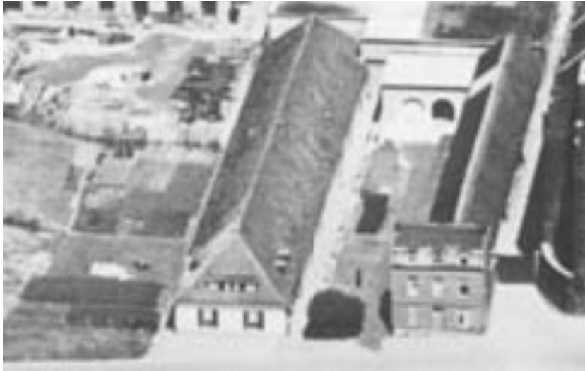
Afb. 55 Uitsnede van de loods uit de luchtfoto vlak voor de inkorting van het zuidelijke deel waarbij de zuidgevel en het dakschild werden gesloopt en een nieuwe zuidgevel met topgevel werd gebouwd. Ook het 19 de -eeuwse huis er rechts naast is toen gesloopt. Afb: RHCL beeldbank, nr. 10549.
