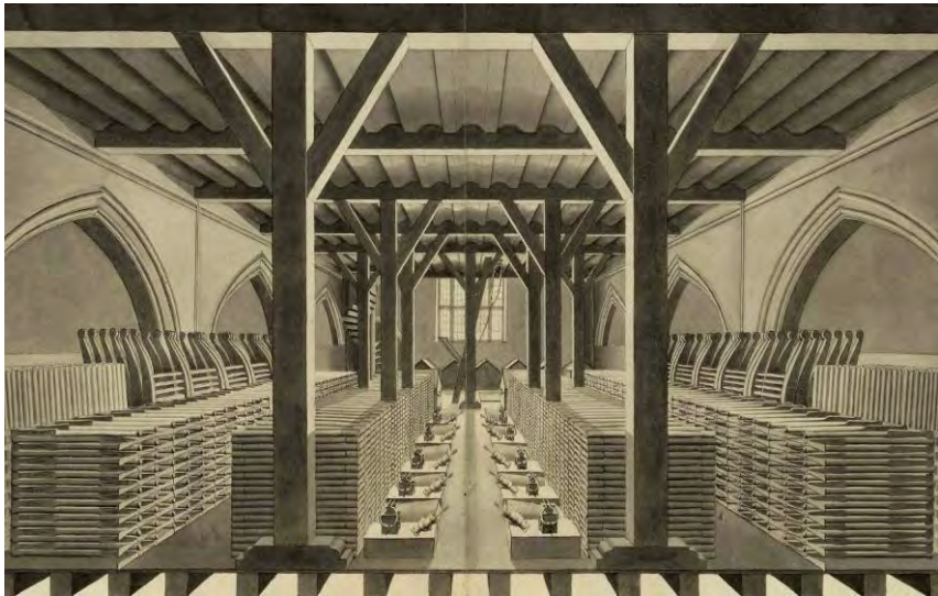
Afb. 72. De 2e verdieping van het kerkship met o.a. opgestapelde schoppen, spaden en pikhouwelen, handmortieren en draagbaren. In het ship was een houtconstructie met verdiepingvloeren ingebouwd. Tekening uit het album van bombardier 5.1.2e van het militair magazijn in het voormalige Oude Minderbroedersklooster, later Sint-Pieterskazerne geheten, in Maastricht. 1759. Beeldbank RHCL
