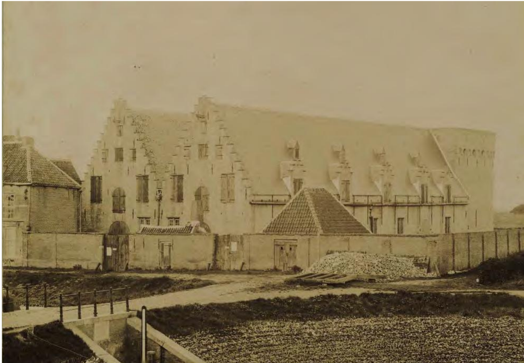
Afb. 70. Lands- en Admiraliteits-Arsenaal of Magazijn-van-Oorlogstuig aan de noordzijde van de haven van Veere, gesticht in 1540 op bevel van 5.1.2e en in 1565 op last van 5.1.2e aanmerkelijk uitgebreid. Het behoorde tot de oudste voorbeelden van een arsenaal in Nederland. In zijn opzet met trapgevels en de als Vlaamse gevels opgezette dakkapellen doet het gebouw denken aan de laat middeleeuwse markthallen (o.a. de vleeshal in Gent). Foto uit 1870-1885. In 1885 werd het complex gesloopt. Beeldbank RCE OF-01202
