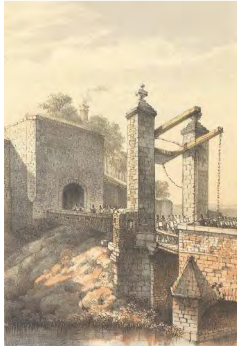
Afb. 3 Tekening van de Boschpoort uit 1872. Deze poort was onderdeel van de tweede stadsmuur. Afb: RHCL beeldbank, nr. 13392.
