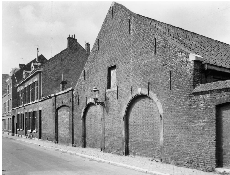
Afb. 81. De affuitloods in de Abtstraat in 1962. De loods is in samenhang met het op de achtergrond zichtbare huis Abtstraat 4 beschermd als Rijksmonument. Foto 5.1.2e , 1962 beeldbank RCE 072666
