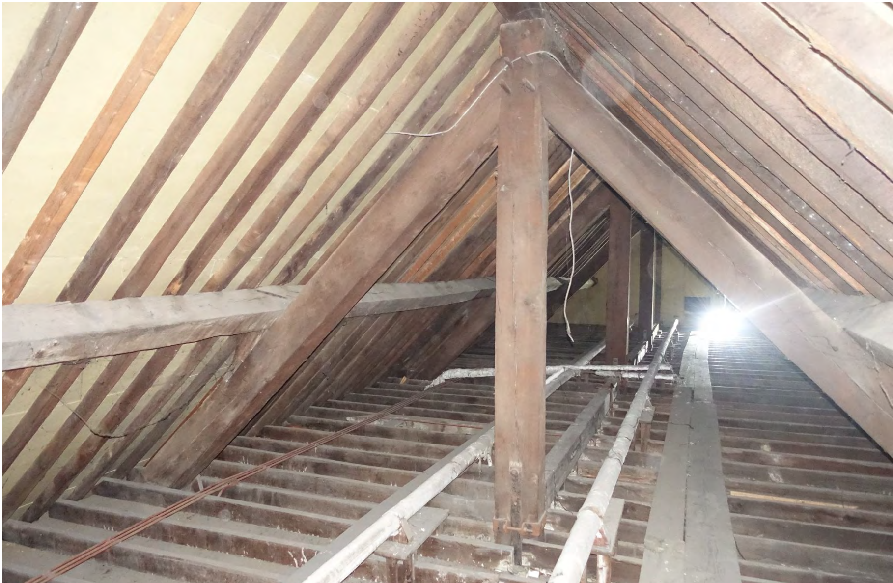
Afb. 112. De vliering boven het noordelijke deel van de loods naar het zuiden gezien. Sommige sporen zijn bij herstelwerkzaamheden vervangen door vuren exemplaren. De balklaag van de vlieringvloer is waarschijnlijk in 1940 aangebracht of mogelijk iets later. Tussen de makelaars van de spanten zijn koppelbalken aangebracht. Hieronder bevond zich in het verleden de turnzaal van KNP. FH MAB 2025
