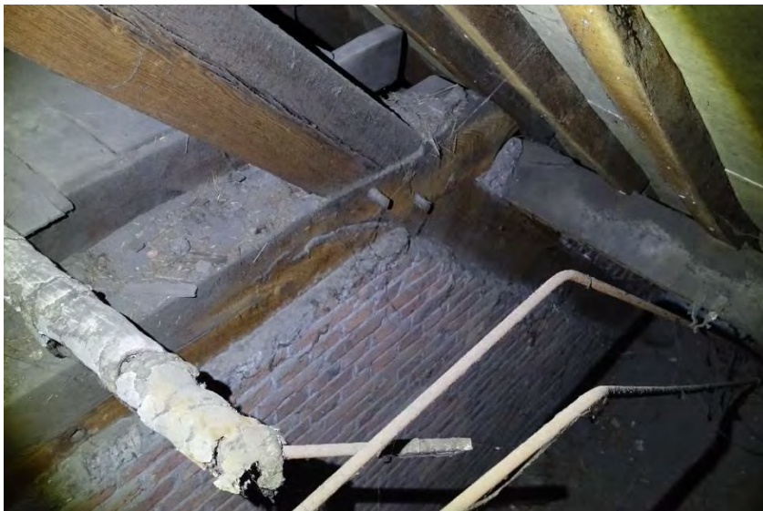
Afb. 105. Onder het dekbalkjuk (zesde juk gerekend vanuit de zuidgevel) bij de stookruimte is in 1940 een muur gemetseld. Hier is geen volledige vlieringvloer aanwezig. FH MAB 2025
