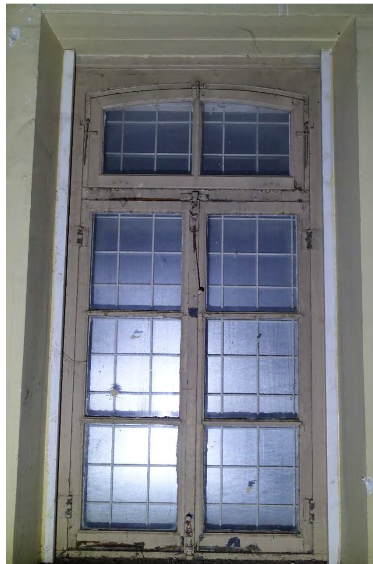
Afb. 40. Binnenzijde van een nog oorspronkelijk venster van de woningen uit de periode 1879-1882. FH MAB 2025
