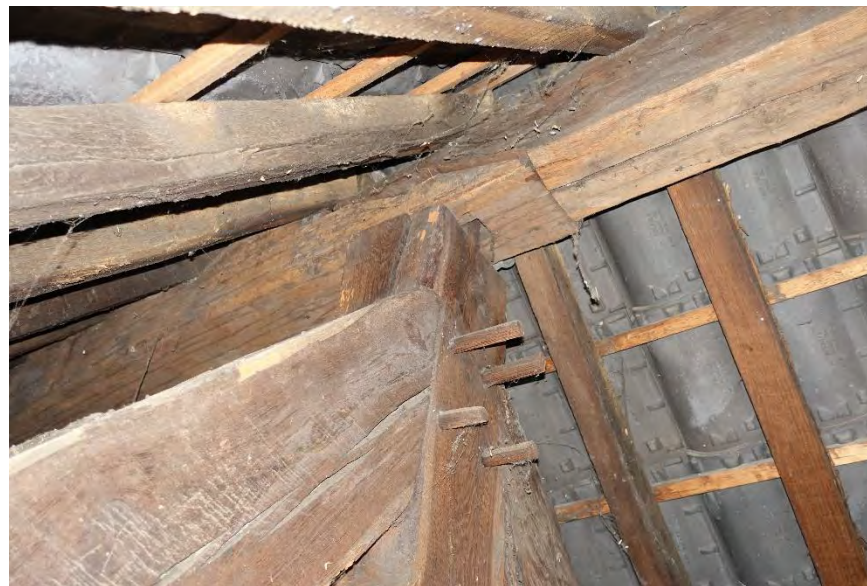
Afb. 106. De nokgording in het zuidelijke deel is op de aansluiting van de makelaar, die in de gording is gepend, voorzien van een haaklas. FH MAB 2025
