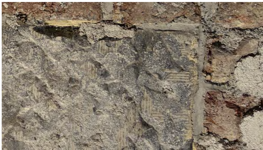
Afb. 115. Detail van de hardstenen duimblok. Tussen de sporen van het latere ruwe hakwerk zijn de resten van de frijnslag met verfsporen zichtbaar. FH MAB 2025
