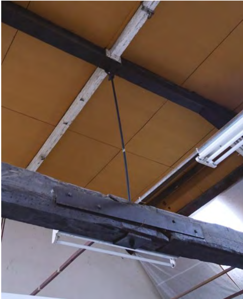
Afb. 51 Detail van een ijzeren anker (hangijzer) tussen de dekbalk en de trekbalk. De trekbalken bestaan uit twee delen die in het midden met een haaklas op elkaar aansluiten en daar dus oorspronkelijk door een console met standvink werden ondersteund. Na verwijdering van de standvink moesten de beide delen van de trekbalk door een stalen strip met elkaar worden verbonden. De stijl op de trekbalk werd ook verwijderd en een hangijzer werd door de trekbalk gestoken, waardoor de trekbalk aan de dekbalk werd gehangen.
