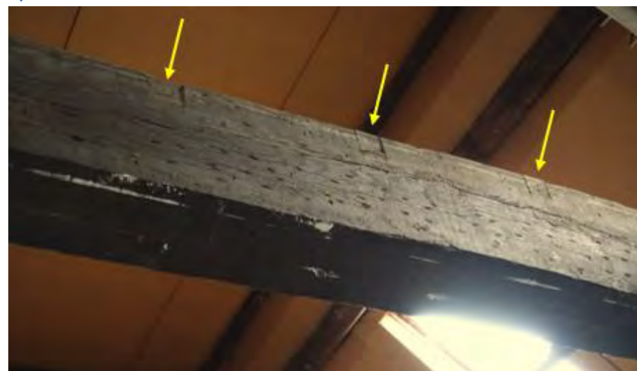
Afb. 94. Detail van een trekbalke waar aan de bovenzijde de kepen, waarin de verdwenen kinderbinten van de oorspronkelijke zoldervloer lagen, goed zichtbaar zijn.
