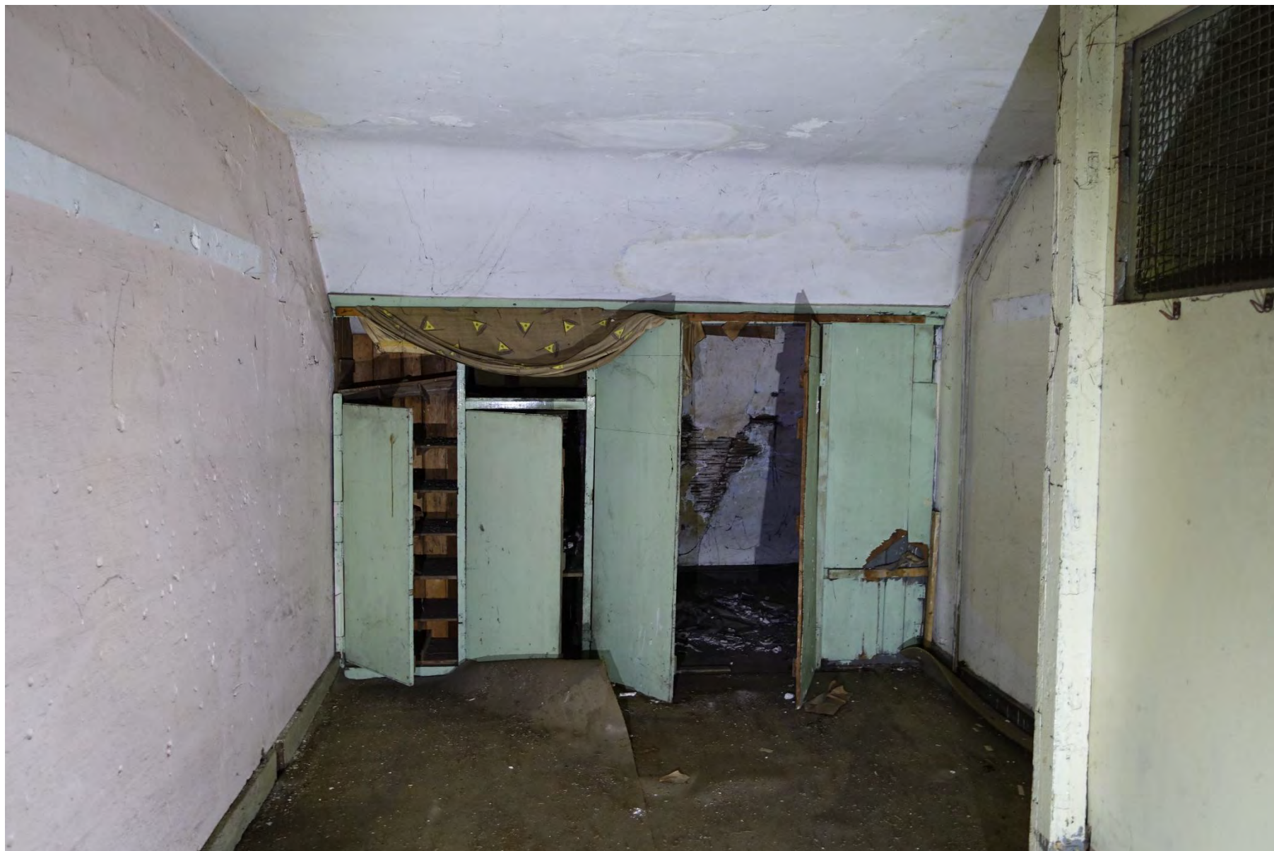
Afb. 43 Zicht in de oostelijke zolderkamer met een knieshot met kasten. Het plafond bestaat uit stuc op latten aangebracht tegen de sporen en vloer van de vliering. FH MAB 2025
