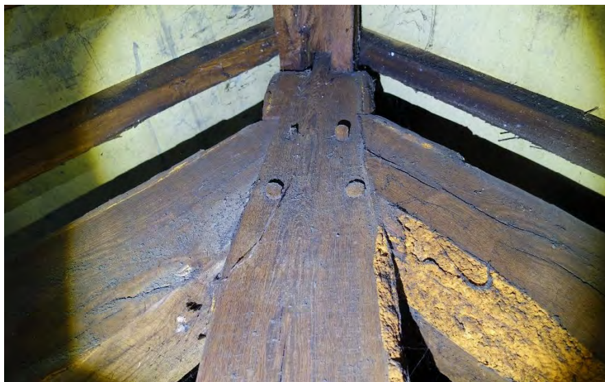
Afb. 101. Detail van de aansluiting van de spantbenen met pen/gat verbinding op de makelaar in het zuidelijke deel. FH MAB 2025
