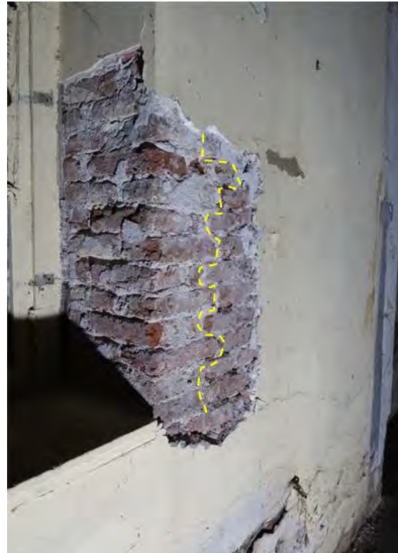
Afb. 114. Vrij gelegd deel bij een venster in het noordelijke deel, westwand. Links van de stippellijn is het bij plaatsing van het venster in 1879 ingeboet metselwerk, rechts ervan bevindt zich oorspronkelijk metselwerk. Ook hier blijkt duidelijk uit dat de huidige muurdikte ook de oorspronkelijke muurdikte is. FH MAB 2025
