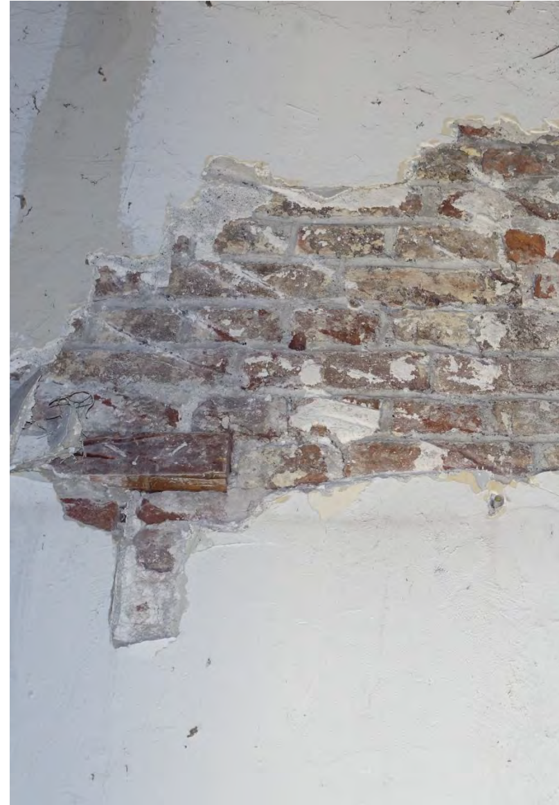
Afb. 121. Vrij gelegd gevelwerk op de oostmuur in het noordelijke deel naast de dichtzetting van een balkgat. Het oorspronkelijke muurwerk heeft door gestreken voegen en resten van een dunne okergele afwerking. FH MAB 2025
