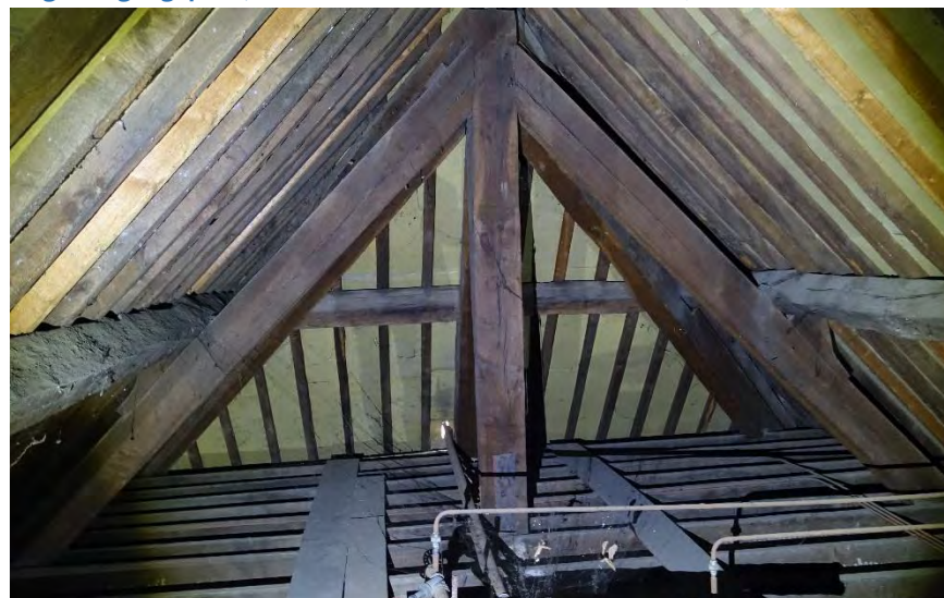
Afb. 107. De vliering in het noordelijke deel gezien naar het noorden met de nokconstructie van het laatste spant. FH MAB 2025
