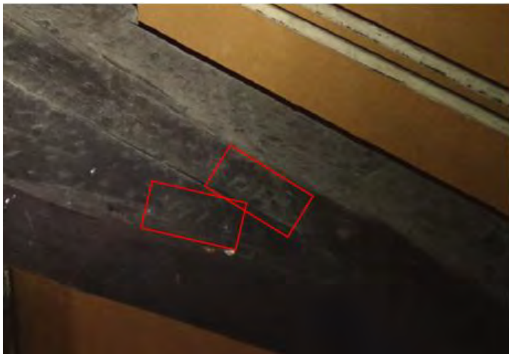
Afb. 98. Telmerk III op een stijl en korbeel van een dekbalkjuk aan de westzijde. DS MAB 2021
