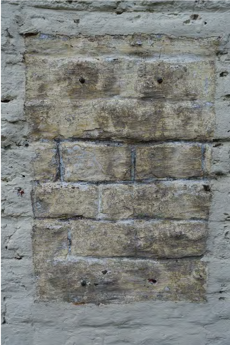
Afb. 120. Een onder een jongere witsellaag vrij gelegd deel in het exterieur waar het metselwerk met een dunne okergele afwerking zichtbaar is. FH MAB 2025
