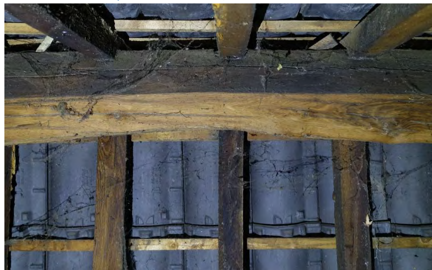
Afb. 103. De sporen zijn ingekeept op de nokgording. FH MAB 2025
