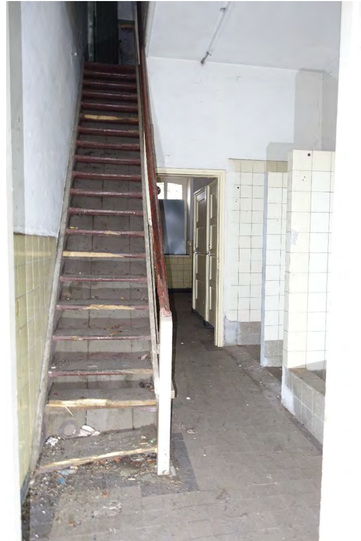
Afb. 42 In het middendeel van de loods is nog een trap naar de zolder van vermoedelijk één van de woningen behouden gebleven. FH MAB 2025
