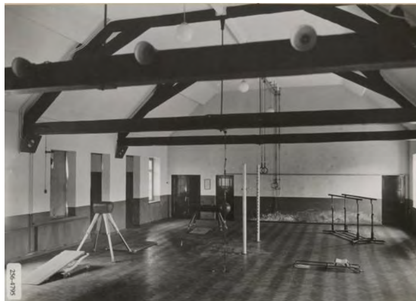
Afb. 61 Turnlokaal van de Koninklijke Nederlandse Papierfabriek te Maastricht (foto 1ste district). Tussen de dekbalken van de kapjucken werd een ligger in metalen schoenen geplaatst waaraan ondermeer de ringen van het turnen werden opgehangen. NA, Collectie / Archief Fotocollectie Arbeidsinspectie, Archiefnr. 2.24.03, inv.nr.2244.
