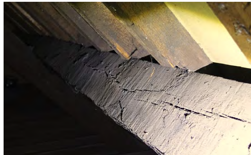
Afb. 110. Detail van de gording aan de westzijde in het noordelijke deel. De balk toont zaagsporen passend in de bouwtijd. FH MAB 2025
