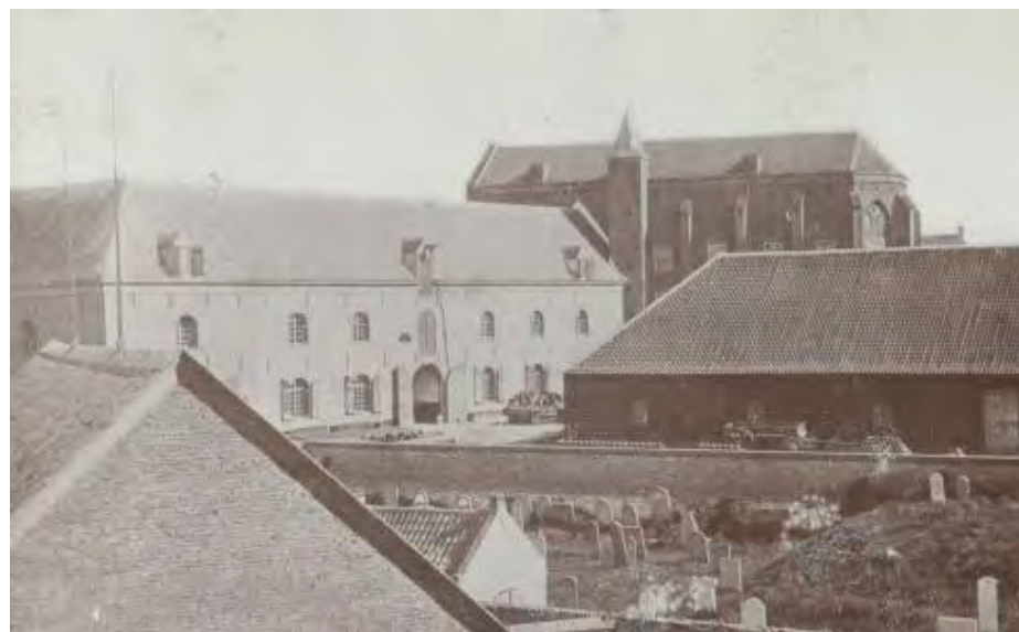
Afb. 77. Het Groot Arsenaal in Nijmegen uit 1824 op een foto van 5.1.2e uit 1880. De hier zichtbare vleugel die haaks stond op de behouden vleugel is gesloopt. Beeldbank RCE OF-06401
