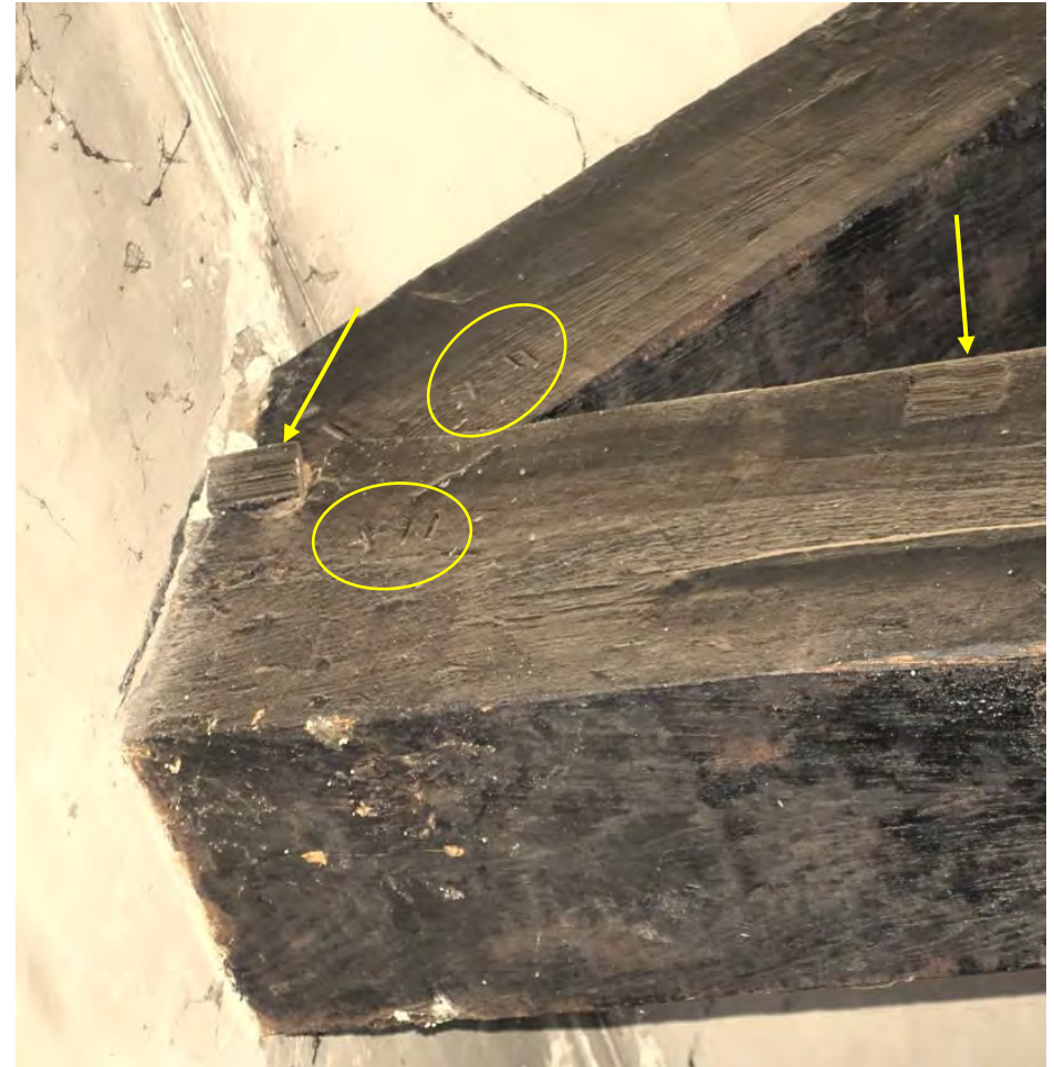
Afb. 99. Detail van het tweede juk in het zuidelijke deel aan de oostzijde met gehakte merken II en X (binnen de gele ovalen). De gele pijlen wijzen naar de kepen van kinderbinten. FH MAB 2025
