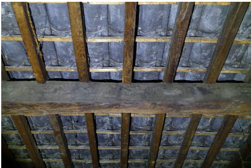
Afb. 104. De sporen zijn deels ingekeept in de gording. Zuidelijke deel, oostelijk dakvlak. FH MAB 2025
