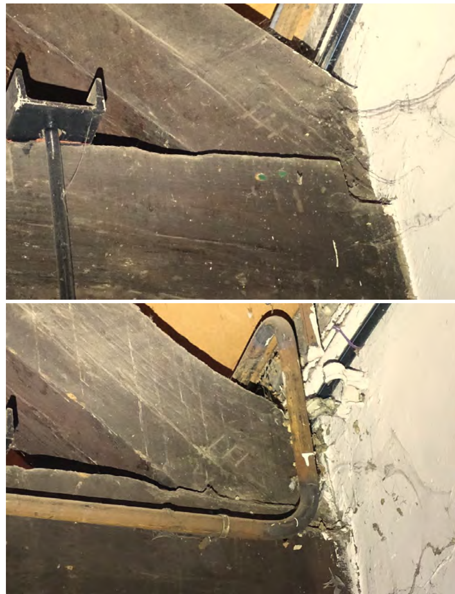
Afb. 96. Twee verschillende jukken met aan de westzijde hiervan twee keer dezelfde telmerken in de vorm van gebeitelde strepen (III). DS MAB 2021
