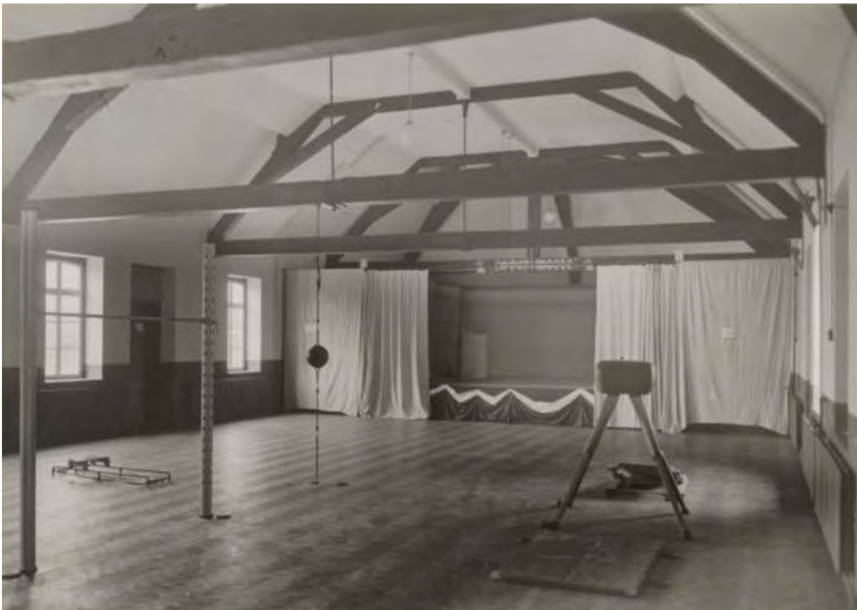
Afb. 63. Turnlokaal met podium tegen de noordgevel van de affuitloods van de Koninklijke Nederlandse Papierfabriek te Maastricht (foto 1ste district). NA, Collectie / Archief Fotocollectie Arbeidsinspectie, Archiefnr. 2.24.03, inv.nr.2245.
