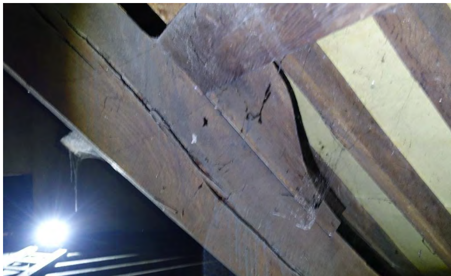
Afb. 108. Detail van een console ter ondersteuning van de gording bij het spantbeen van de nokconstructie. FH MAB 2025
