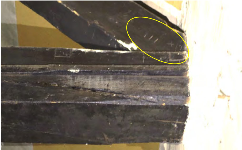
Afb. 97. Detail van het tweede juk in het zuidelijke deel aan de westzijde met gehakte merken III en X II (binnen het gele ovaal). FH MAB 2025
