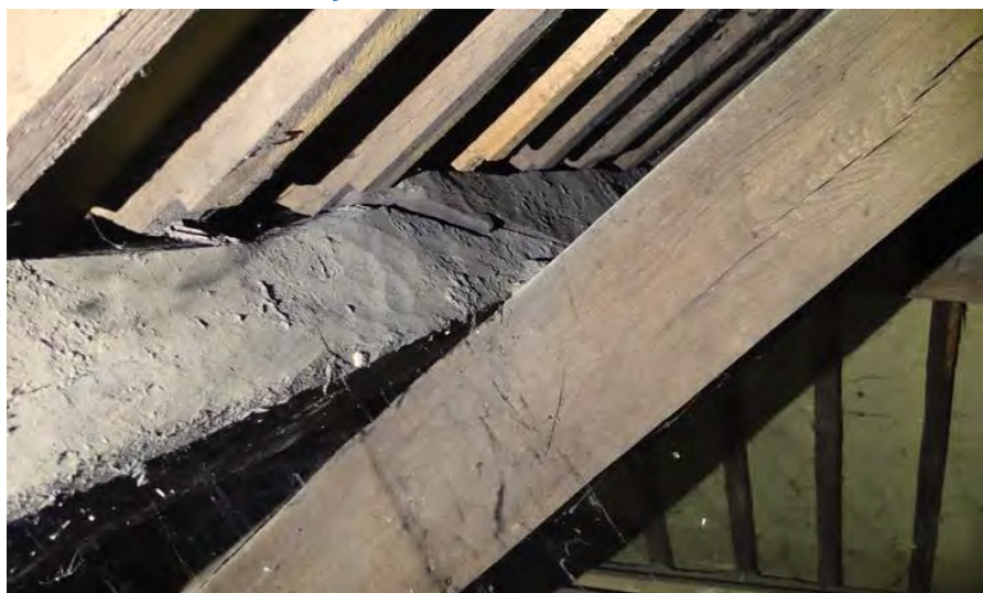
Afb. 109. Detail van de gording aan de westzijde in het noordelijke deel. De balk toont sporen van een niet in de bouwtijd passende gedisselde afwerking wat wijst op een oudere hergebruikte balk. FH MAB 2025
