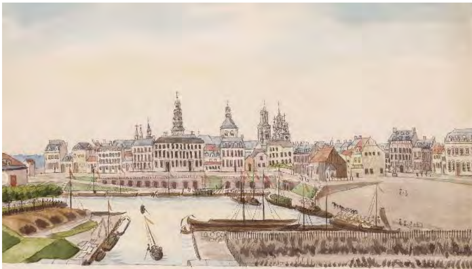
Afb. 18 Bassin gezien richting het zuiden op een prent uit 1840. Op de voorgrond de aansluiting van de Zuid Willemsvaart. Afb: RHCL beeldbank, nr. LGOG 471A.
