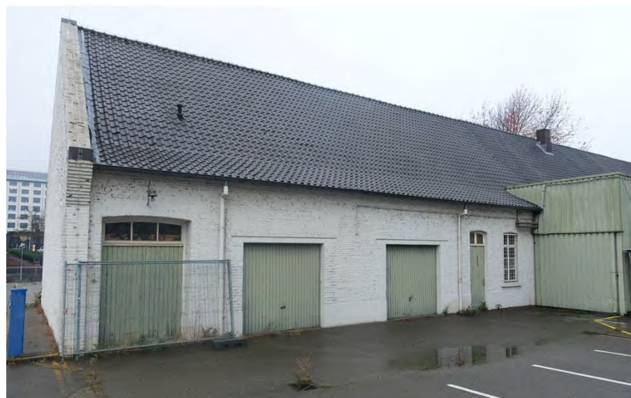
Afb. 66. Het zuidelijke deel van de oostgevel in 2021 met rechts nog een aanbouw van damwandplaat. DS MAB 2021
