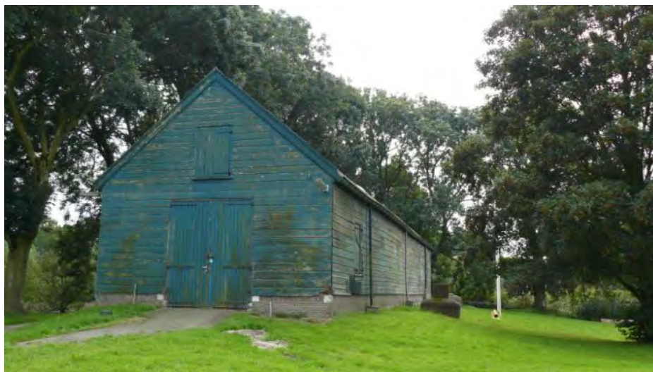
Afb. 86. De houten affuitloods Amstelhoek. Deze Affuitloods, (Militaire Opslagplaats), staat in de nabijheid van Fort Uithoorn.
