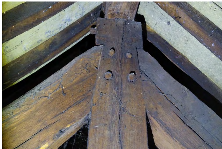
Afb. 102. Detail van de aansluiting van de spantbenen met pen/gat verbinding op de makelaar in het zuidelijke deel. FH MAB 2025
