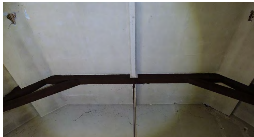
Afb. 62. De onderslag die met metalen schoenen in de dekbalken van de kapjucken is bevestigd. Hieraan werden onder meer de ringen van de turnzaal bevestigd. FH MAB 2025
