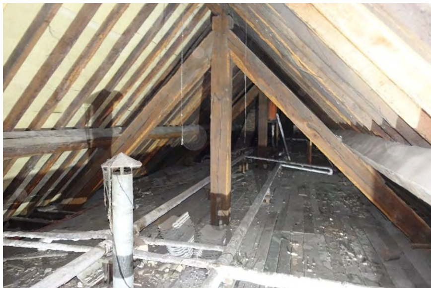
Afb. 100. De vloering met de nokconstructies in het zuidelijke deel naar het zuiden gezien. FH MAB 2025
