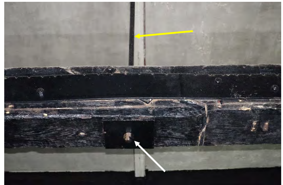
Afb. 52. Detail van de door een stalen strip onderling gekoppelde delen van een trekbalk. Het hangijzer (gele pijl) is met een schroefdraad door de beide delen van de trekbalk en een stalen plaat gestoken en vast gezet met een moer (witte pijl).
