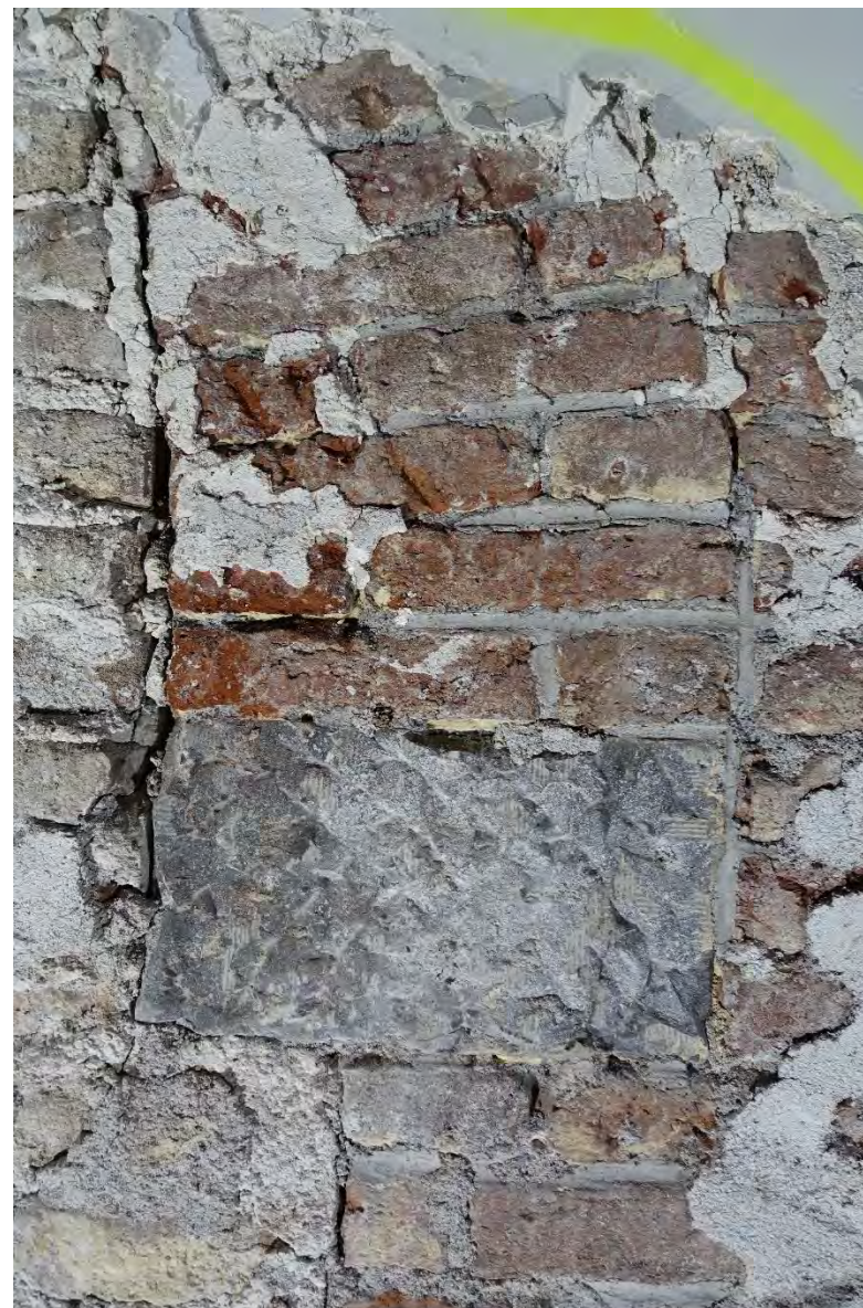
Afb. 116. Het vrij gelegde duimblok en de aanzet van de boog. Ook op de baksteen zijn sporen van de okergele afwerking gevonden. FH MAB 2025
