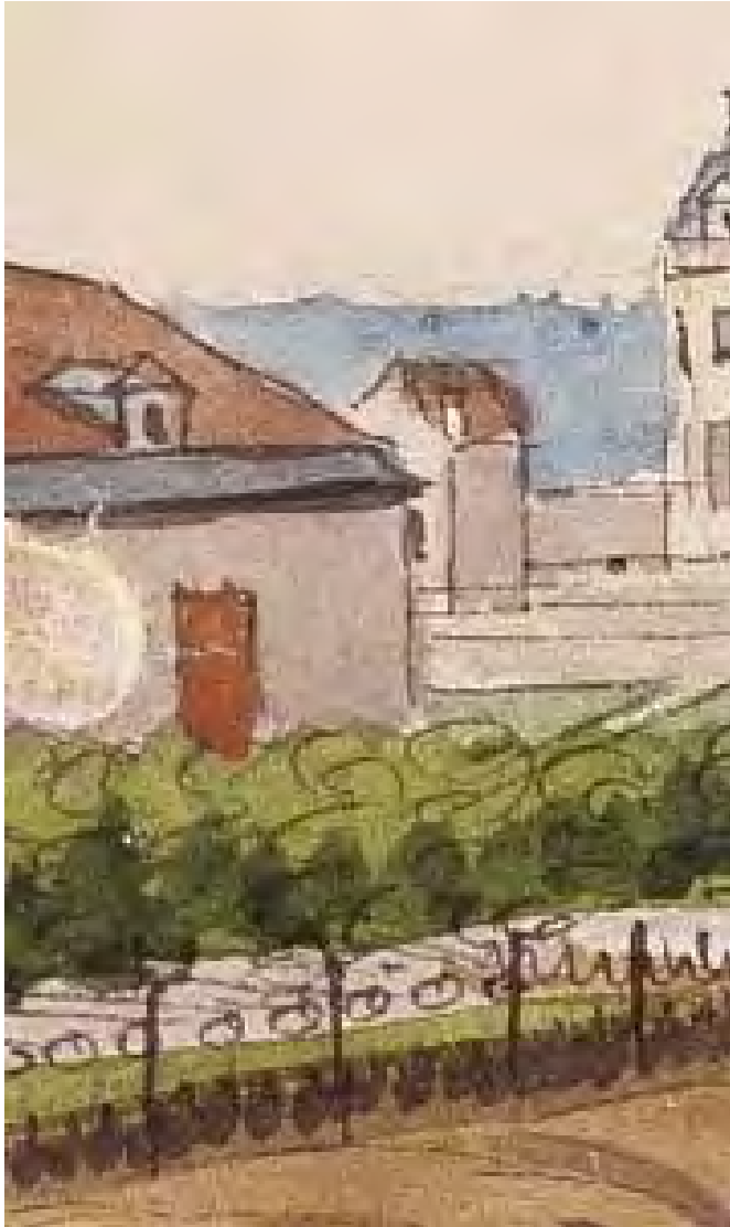
Afb. 31 Uitsnede uit de prent van het Bassin uit 1840 met links de westgevel van de affuitenloods. Het onderste, geknikte deel van het dak lijkt een andere bedekking te bezitten. Afb: RHCL beeldbank, nr. LGOG 471A.
