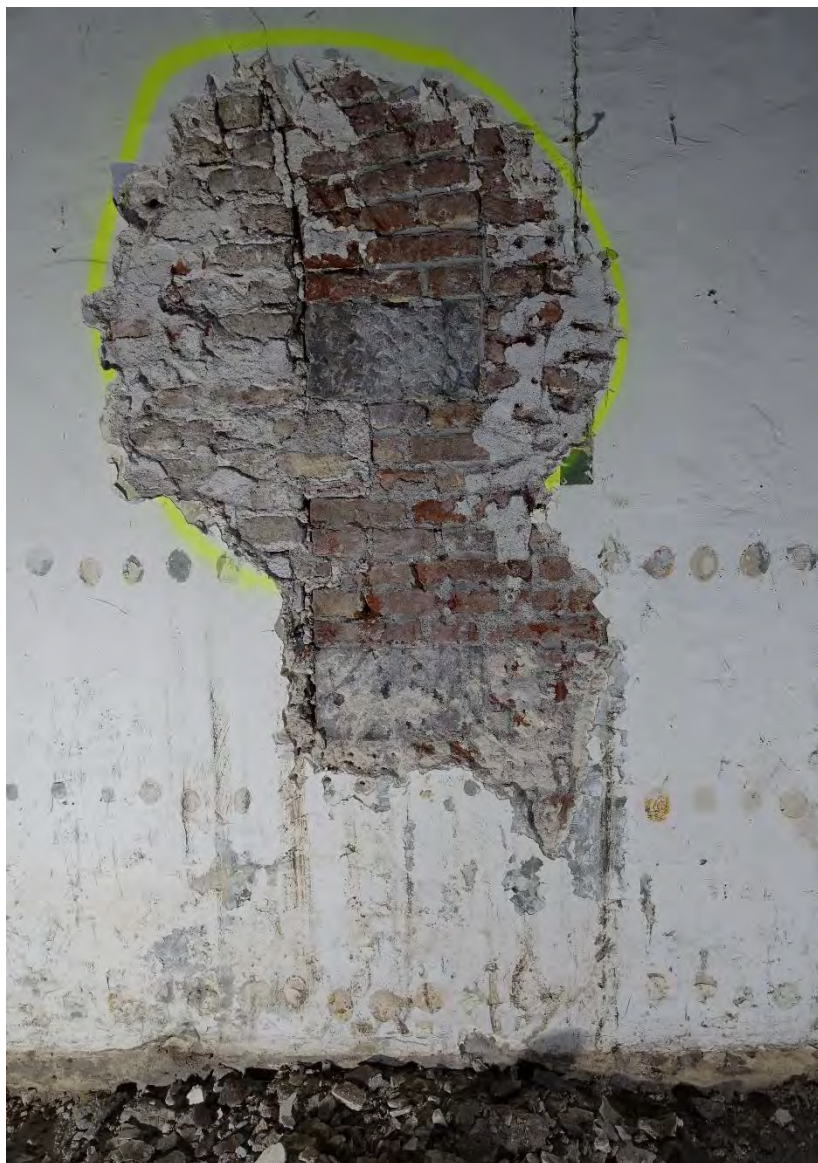
Afb. 117. Het gehele vrij gelegde vlak met halverwege de doorgang nog een tweede hardstenen duimblok. Voor het latere pleisterwerk heeft men de blokken ruw behakt waarbij de oorspronkelijke frijnslag deels werd weggehakt. FH MAB 2025
