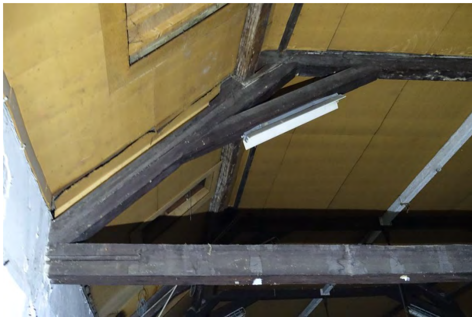
Afb. 92. Westelijk deel van een dekbalkjuk in het noordelijk deel van de loods.
